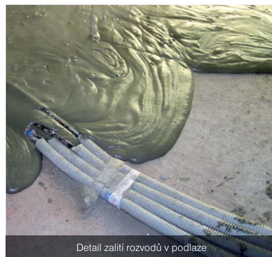
Lití Porimentu – spádová vrstva
