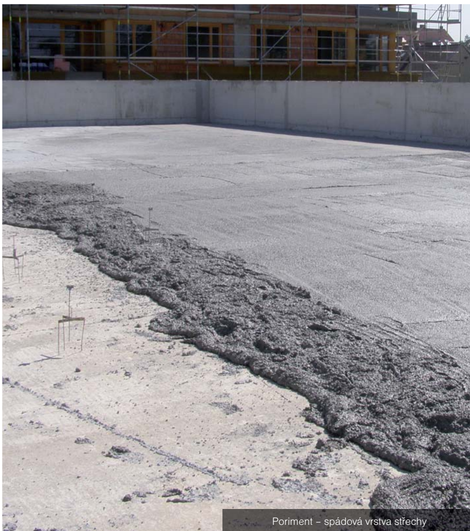
Lití Porimentu – spádová vrstva
