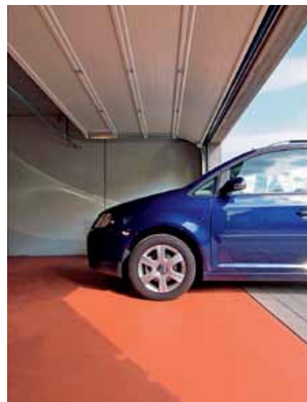
Probarvená podlaha CEMFLOW® Look v garáži RD
