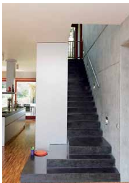
Interiérové schodiště z barevného betonu Colorcrete®
